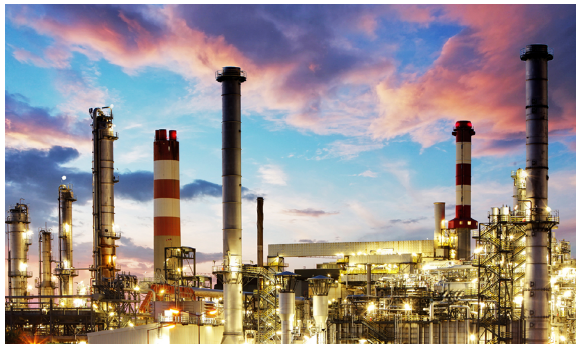
Нефтеперерабатывающий завод в Данготе,
