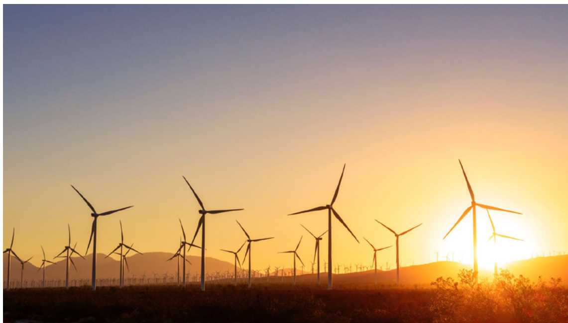
Ветроэлектростанция Адама II, Эфиопия
