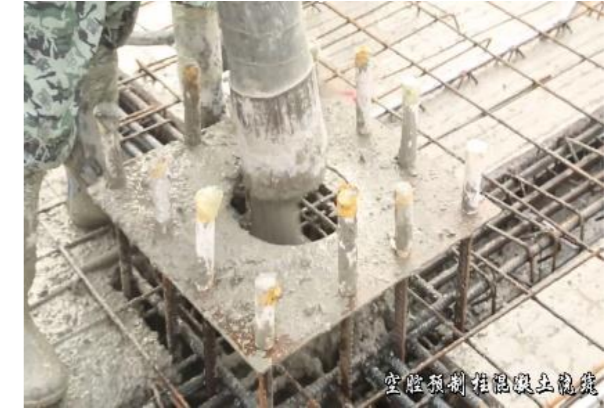
混凝土浇筑
