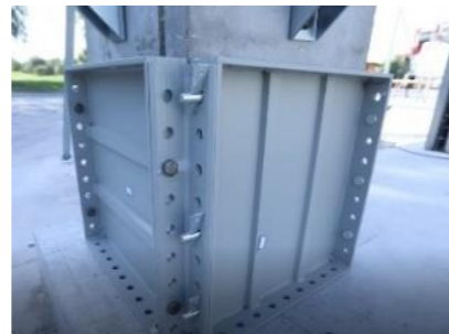
柱底模具安装
