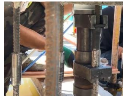
边筋套筒连接
