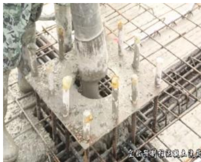
混凝土浇筑
