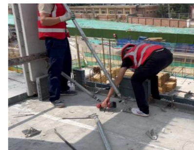
底部封堵模具安装
