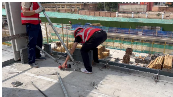
对拉螺杆安装
