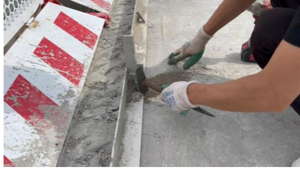
钻孔及胀栓安装
