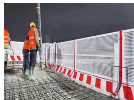
混凝土浇筑
