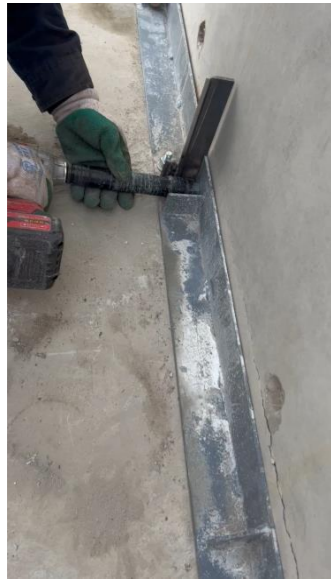
底部封堵工装紧固
