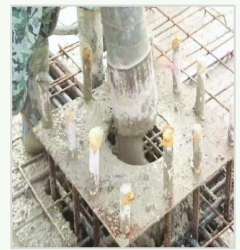
➤ 浇筑: 钢筋固定、浇筑
