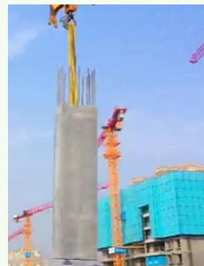
➤ 起吊: 构件起吊转运
