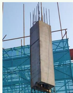
➤ 起吊: 构件起吊转运
