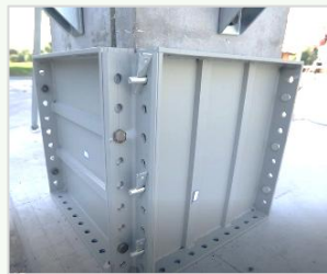
➤ 模板: 现浇区模板安装
