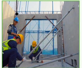
空腔墙支撑安装
