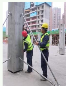
➤ 紧固: 检查调整紧固
