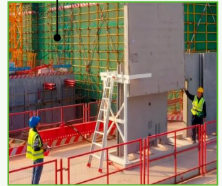
空腔墙支撑安装
