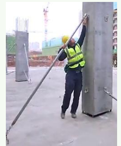
➤ 支撑: 双侧斜支撑安装
