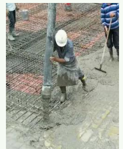
➤ 浇筑: 空腔及板面浇筑
