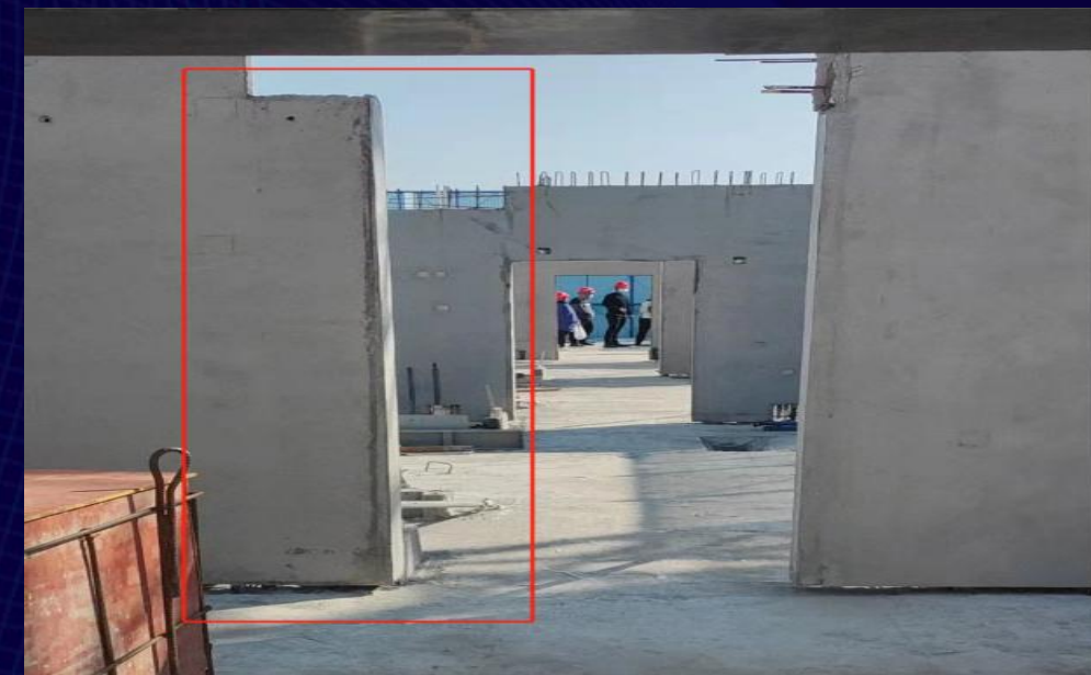
门窗洞口封堵一体化
