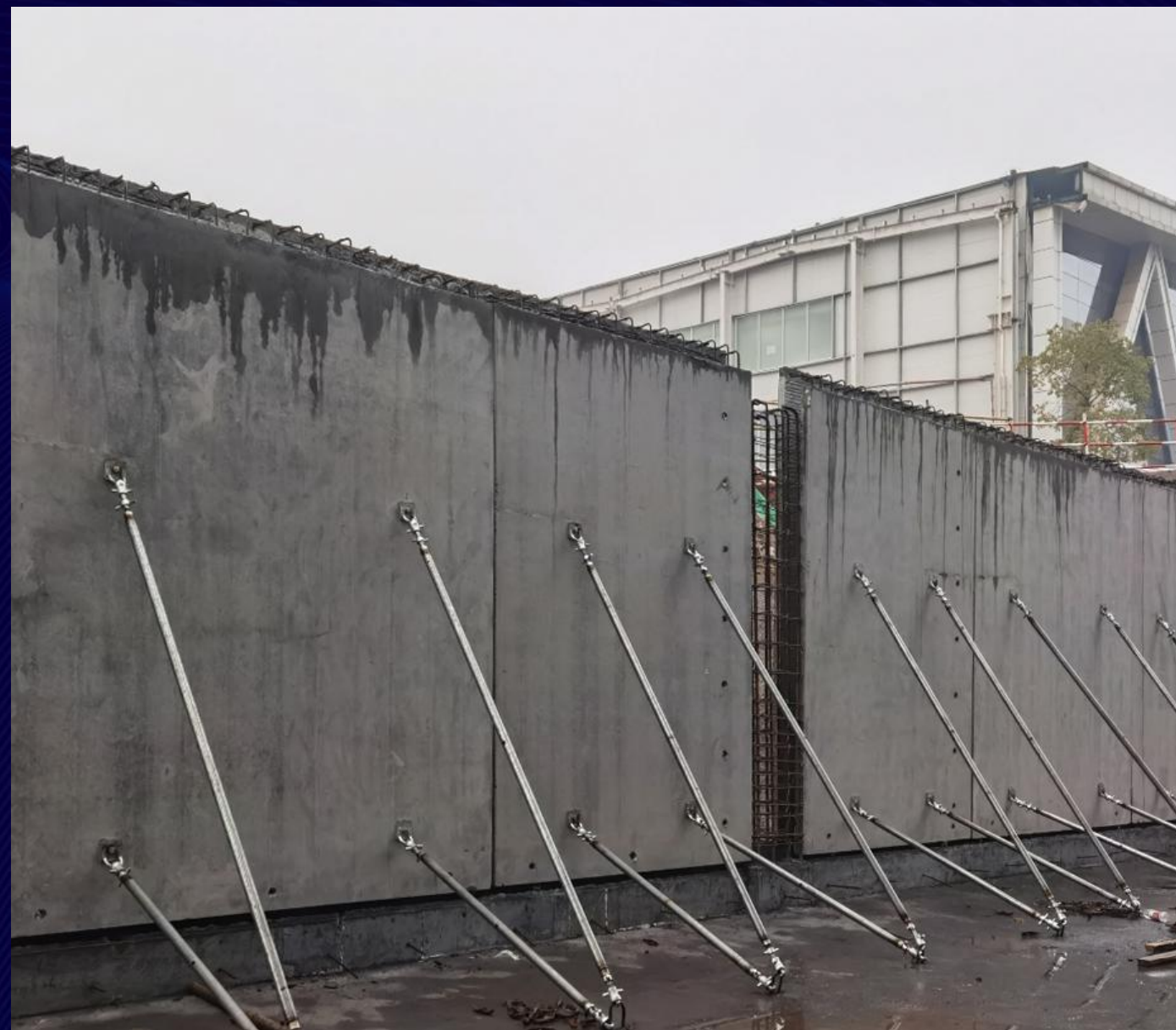
地下室外墙构件安装
