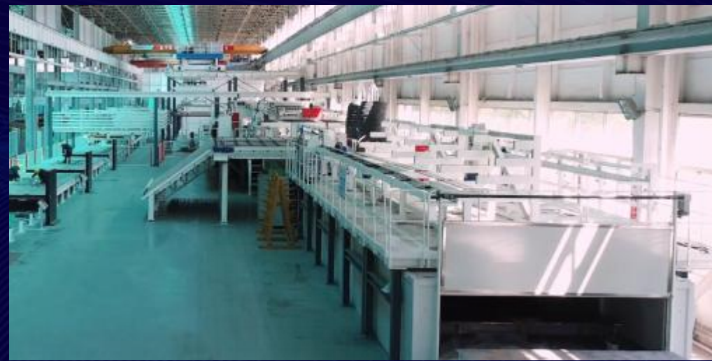
钢筋切割、弯折、焊接
