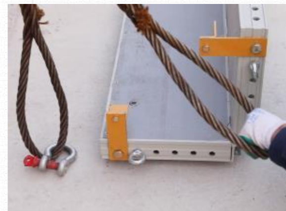
安装好吊环，墙板上部定位挂钩
