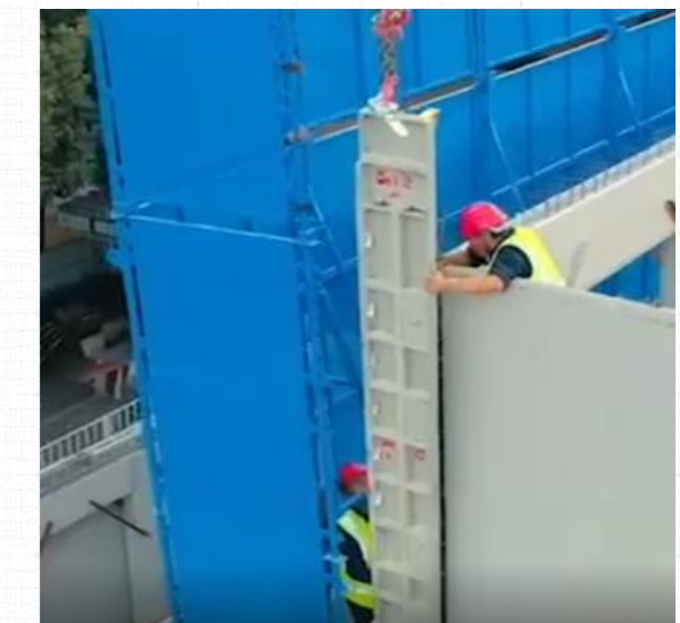
吊装安装，浇筑混凝土后，同样吊装拆除
