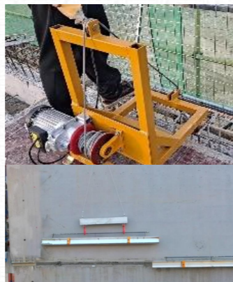
浇筑混凝土后通过定制的电动或手动工具拆除
