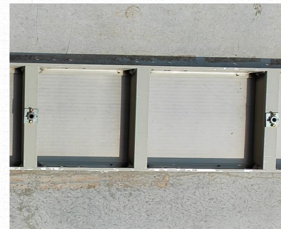
外侧模板提前安装螺纹固定件
