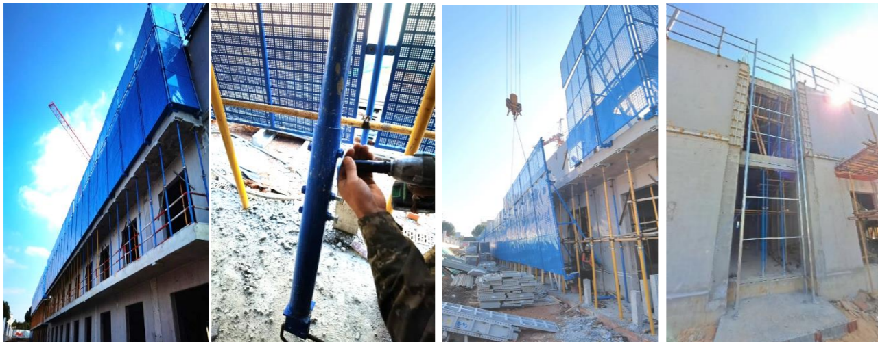
后浇阳台跨层防护
