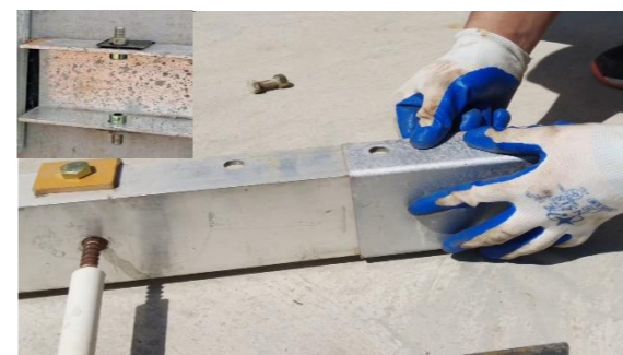
工装连接板、封堵板安装
