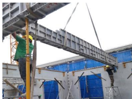
梁模整体吊装
