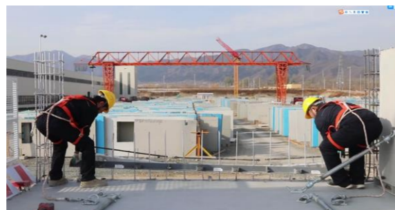
底部封堵工装就位
