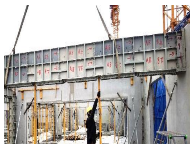
独立支撑安装
