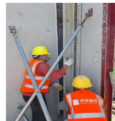
内侧模具安装
