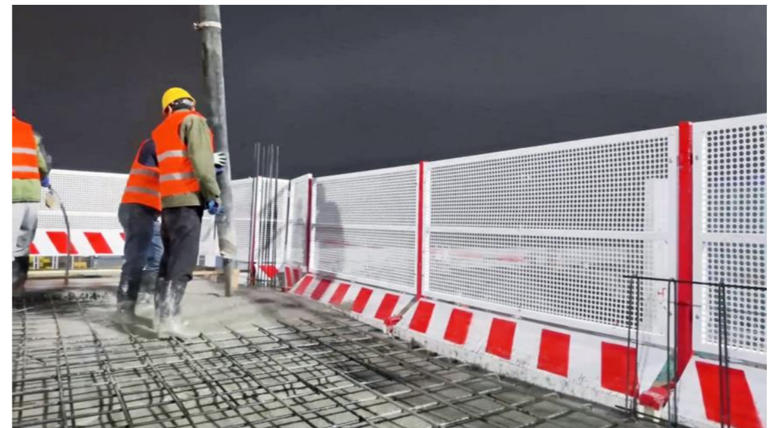
混凝土浇筑
