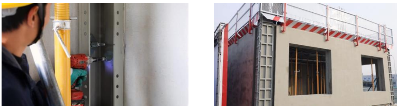
对拉螺杆拆除
